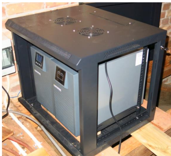
De noodvoeding voor de kroonluchters.
