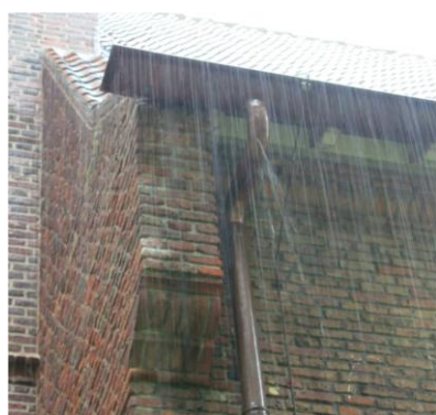
Effect verstopte afvoer bij en stortbui.
